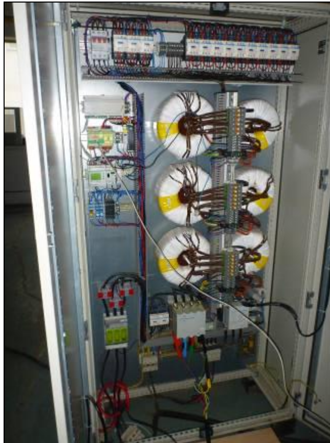
obr. 3-1 Místo připojení analyzátoru.
