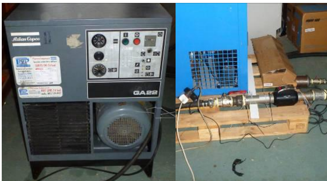
obr. 3-3 Kompresor napájený z rozváděče a průtokoměr.
