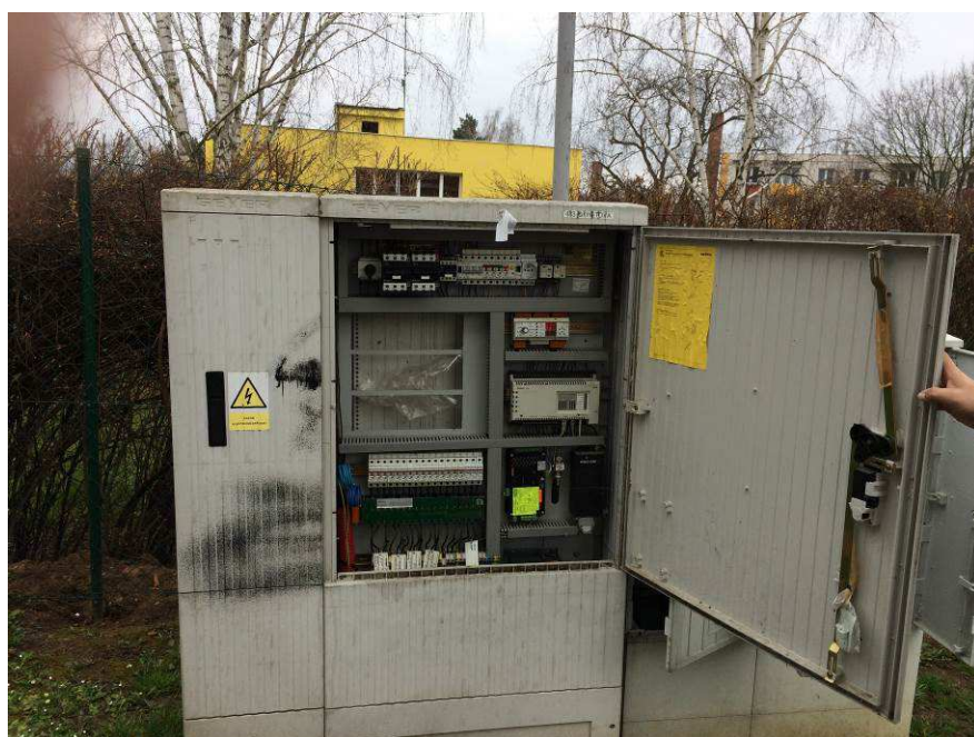
Obrázek 3 : Skříň přípojného místa.
